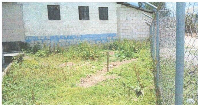
Foto 1: Mejoramiento de Fosa septica
