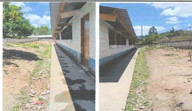
Foto 4: Mejoramiento de cuneta y muro de contención
